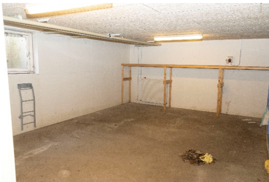
Sikringsrum/opbevaring i kælderen
