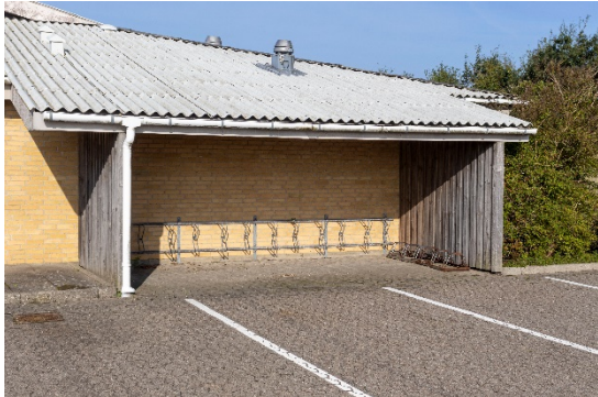
Overdækket cykelskur beliggende mod øst
